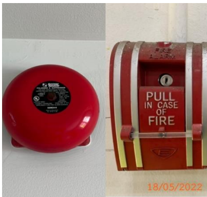
รูปที่ 3-65 อุปกรณ์ในระบบป้องกันและสัญญาณเตือน อัคคีภัย
