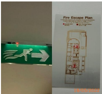
รูปที่ 3-67 ป้ายและเครื่องหมายหนีไฟและ แผนผังเส้นทางหนีไฟ
