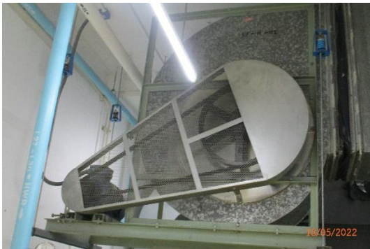
รูปที่ 3-71 พัดลมระบายอากาศ
